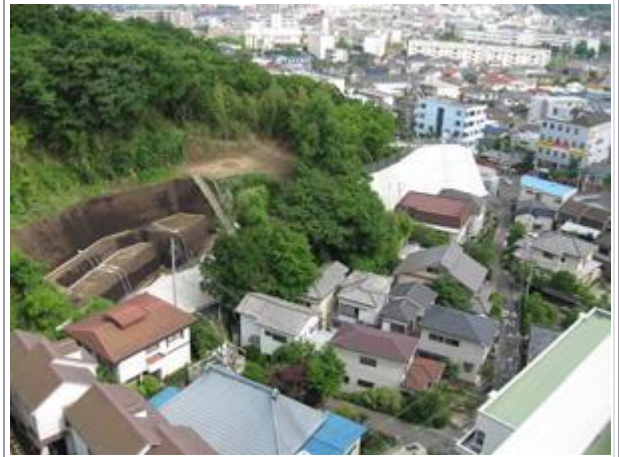
▲遺跡遠景(北西から)
