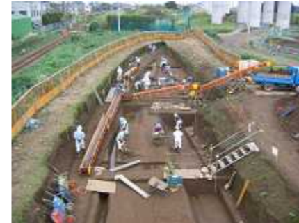
人力掘削+ベルトコンベアー
