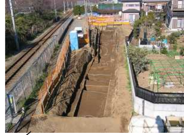
第2次調査 区(倉見川端遺跡) 古墳周溝と中近世の溝
