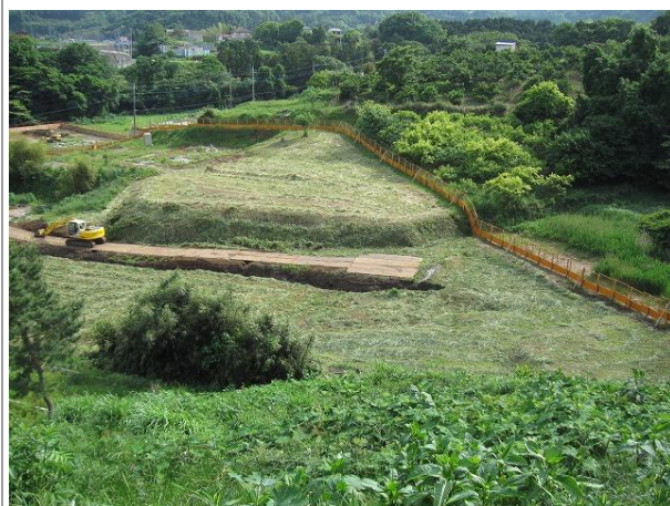
▲4区 調査区遠景
