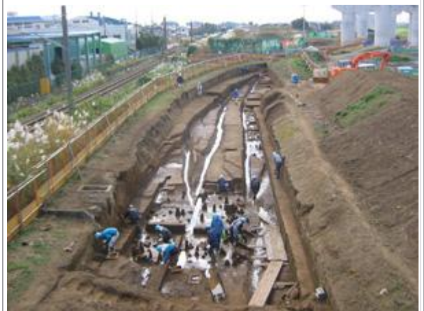
▲Ⅷ-2区 近世の溝と中世の竪穴状遺構の調査
