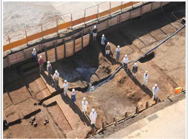
▲45号溝 完掘状況
