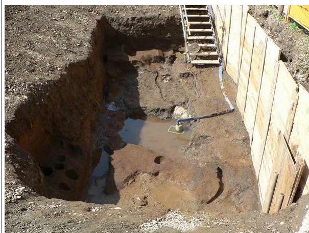
▲調査地点全景(奈良・平安時代遺構群)
