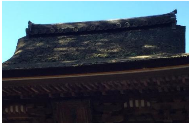
写真8 薨棟の例・石上神宮の屋根・
