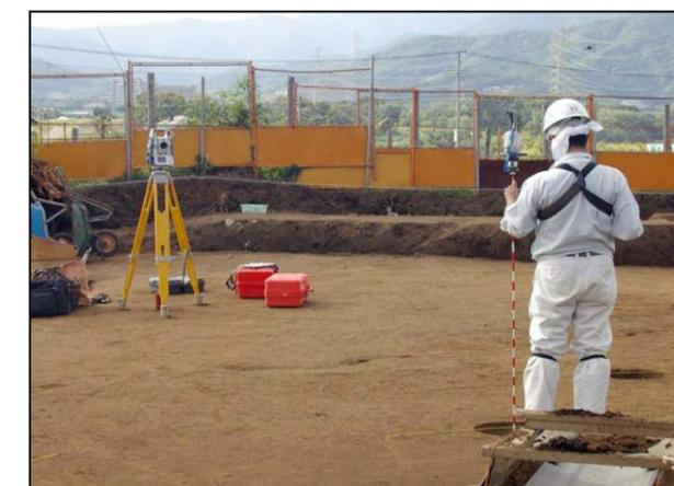
光波測距儀を使用した測量
