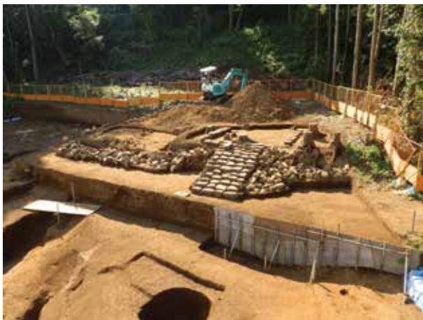
『安楽寺』石段・石垣（北東から）
