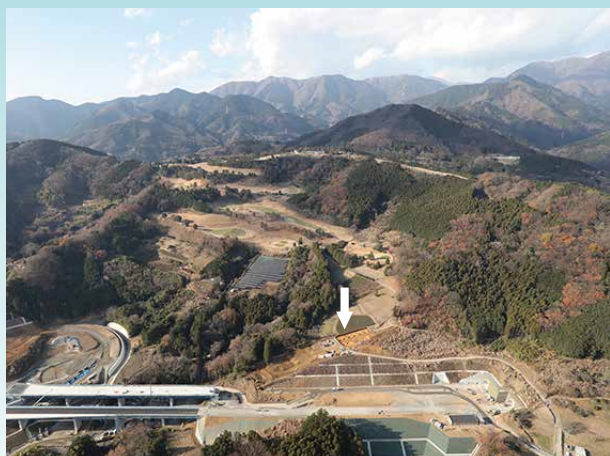
1. 柳川竹ノ上遺跡 遠景（南東から）
